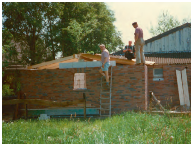
Der Anbau für den neuen Lagerraum wurde gerichtet. Unter anderem von Harald Darlath, Okko Betten und Johann Meier
