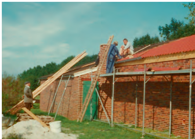
Das Dach wird neu eingedeckt. Über den alten Bitumenwellplatten wurden Latten und Dachpfannenblech montiert.
